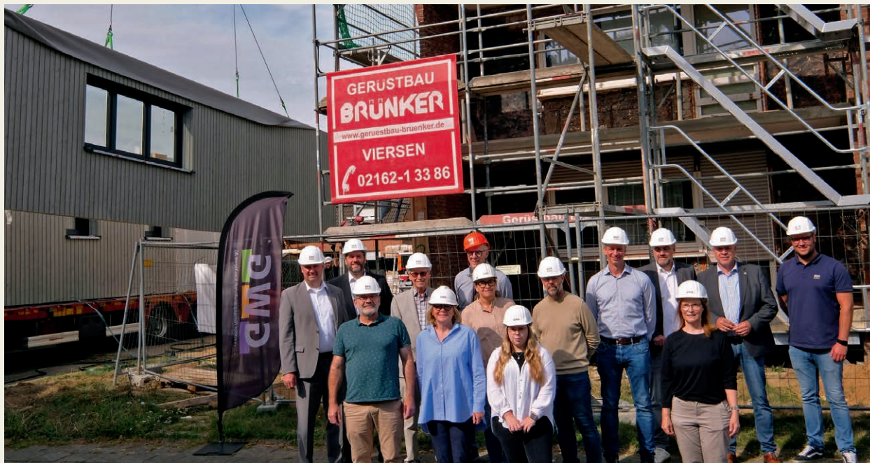
Anlässlich der Anlieferung und des Einbaus der vorgefertigten Fassadenelemente beim Projekt Modernisierung als serielle Sanierung von drei Mehrfamilienhäusern in Schwalmtal (v.l.n.r.): Michael Aach (Vorstand GWG Kreis Viersen AG), Andreas Gisbertz (Bürgermeister), Rainer Heemsoth (Prokurist B&O Bau), Günter Werner (Aufsichtsratsvorsitzender GWG Kreis Viersen AG), Nicole Kreuzer (GWG Bauabteilung), Falk Figgemeier (Leiter GWG Bauabteilung), Nicole Brandner (GWG Bauabteilung), Lea Heise (GWG Bauabteilung), Jörn Wehrmann (GWG Bauabteilung), Alexander Bex (Assistent des Vorstandes GWG), Mike Zander (Prokurist GWG), Waltraud Schmelz (GWG Bauabteilung), Bernd Gather (Fachbereichsleiter der Gemeinde Schwalmtal). Foto: GWG Kreis Viersen AG
