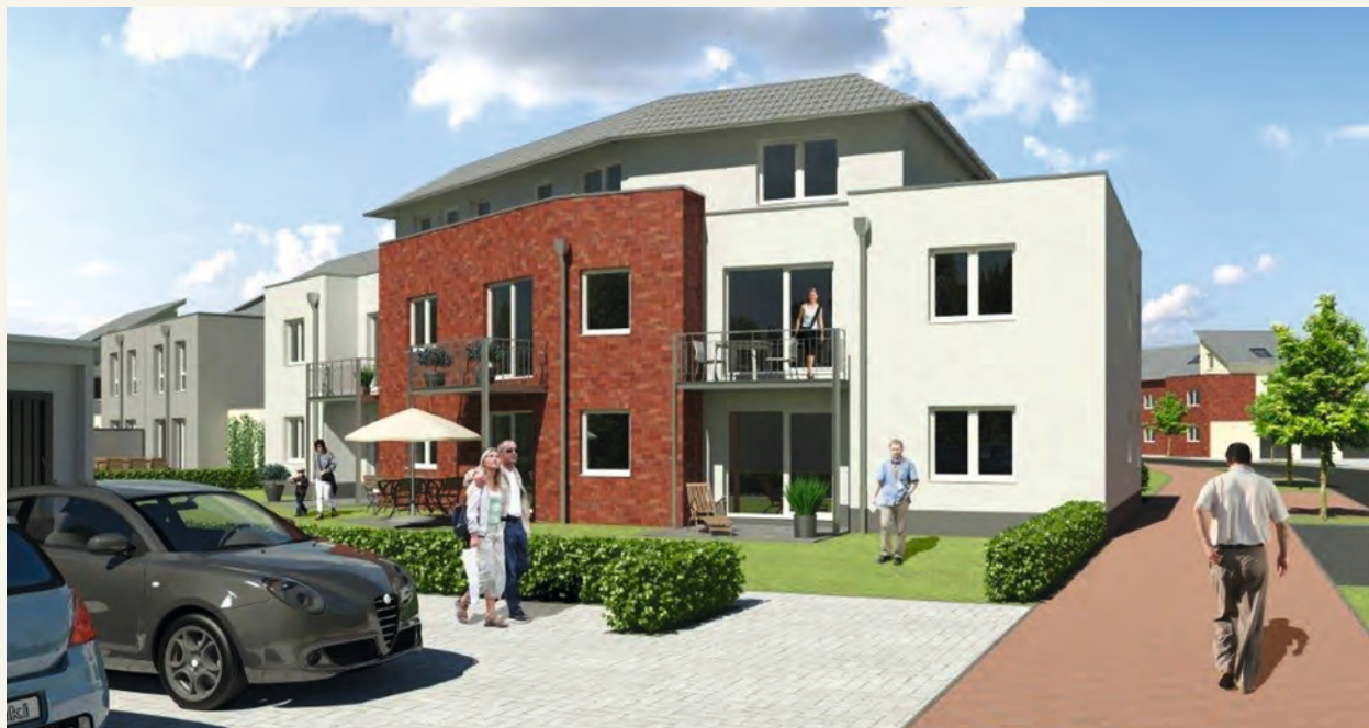
Mehrfamilienhaus mit acht Wohneinheiten – aktuell im Bau
