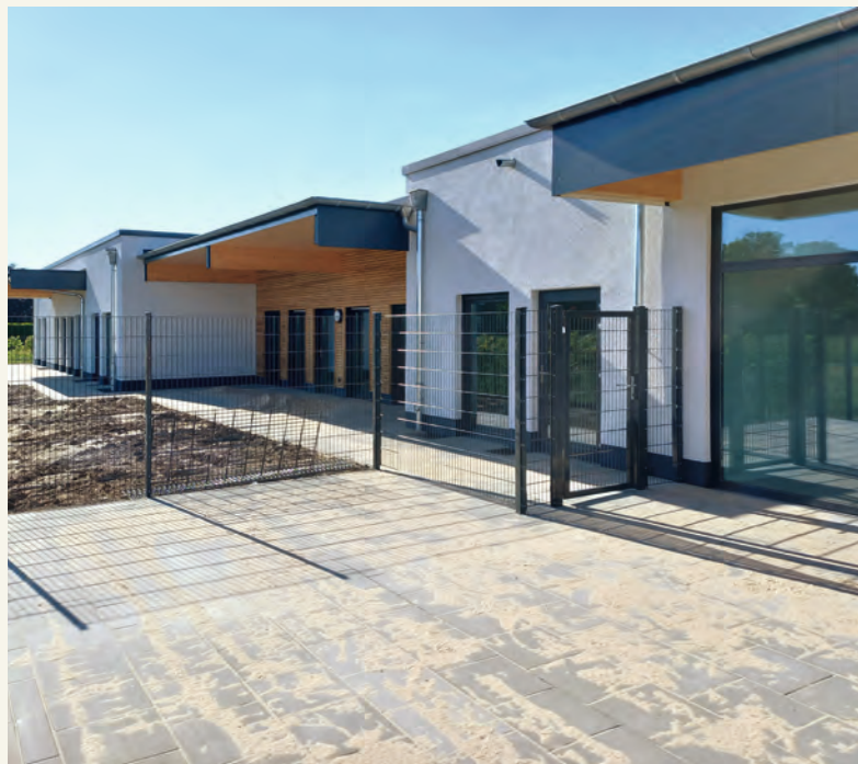
Die neue Kita in Willich-Schiefbahn bietet Platz für ca. 70 Kinder in insgesamt vier Gruppen
